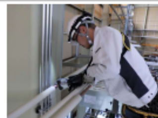
写真:火なし工法
