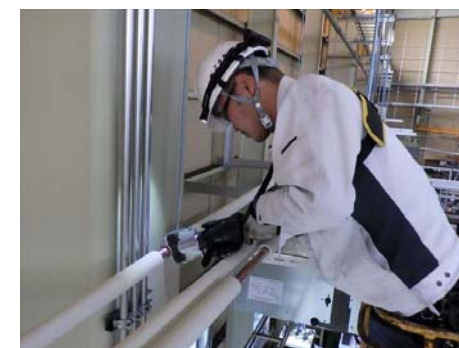
写真：火なし工法
